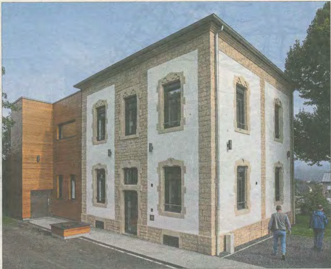
Das alte „Rollenger Paschtoueschhaus“ wurde erneuert und um einen modernen Anbau mit Lift erweitert. In der Sitzgelegenheit vor dem Gebäude bietet ein Fenster Einblick in den gewölbten Keller. (FOTOS: GUY JALLAY)
